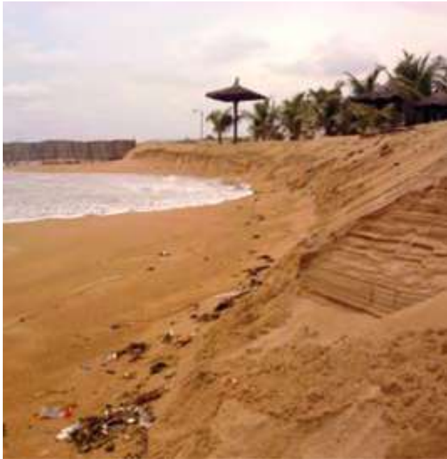
Importante érosion (plage réflexive) dans le secteur face au port (Source antenne nationale MOLOA du Bénin)
