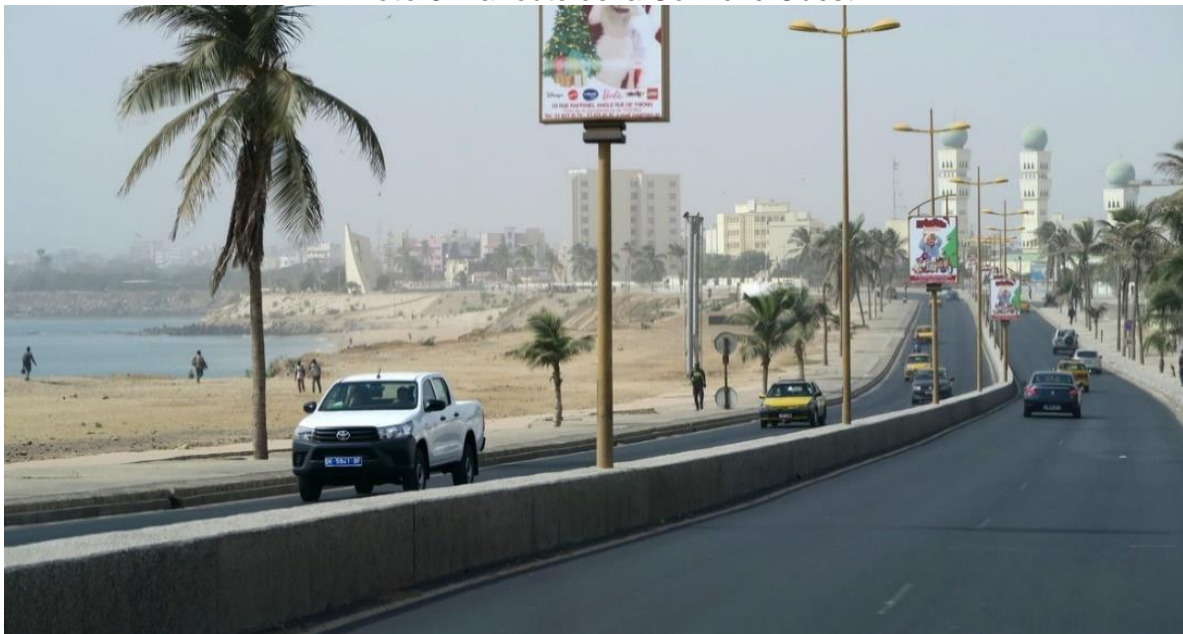
Photo 8: La route de la Corniche Ouest
