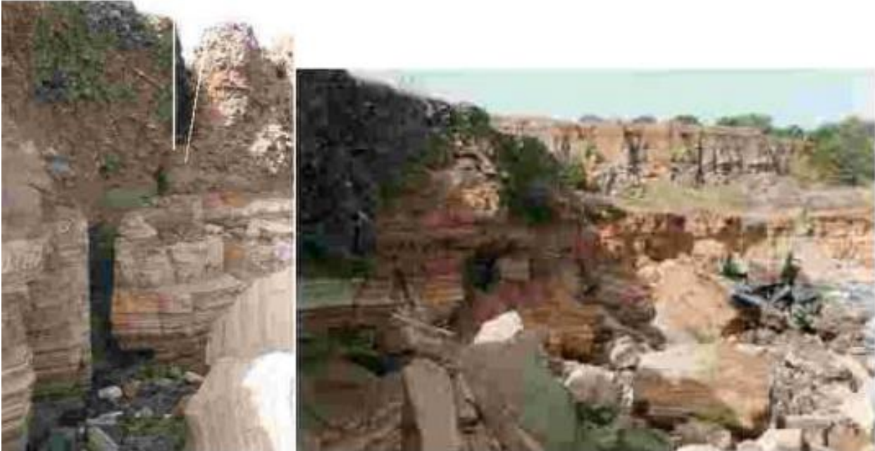
Photo 4 : Ouverture des fractures et basculement des blocs dans la carrière de Mermoz
