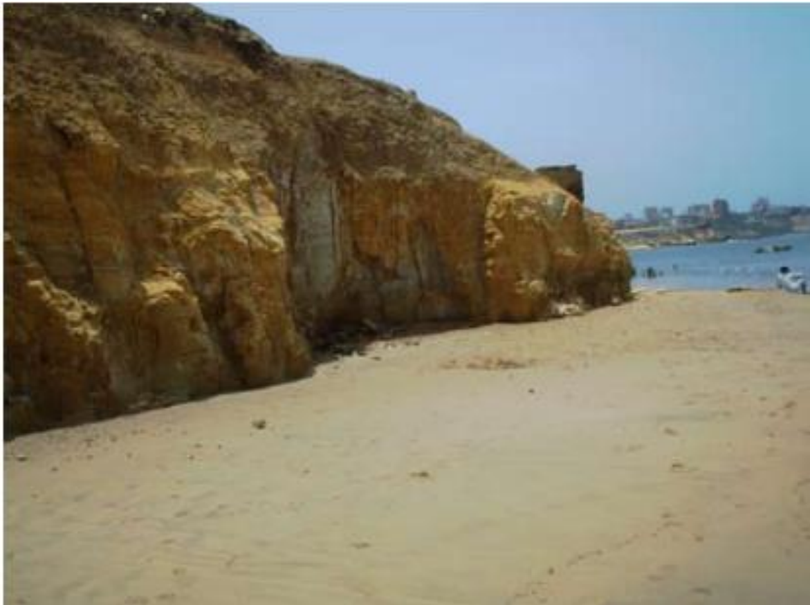
Photo 3 : Falaise limoneuse de la porte du Millénaire
