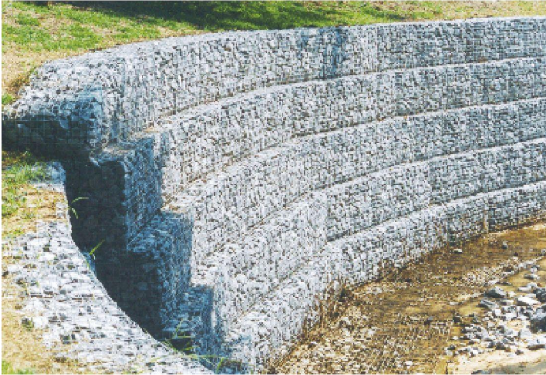
Photo 9 : Exemple de falaise aménagée avec un mur en gabion
