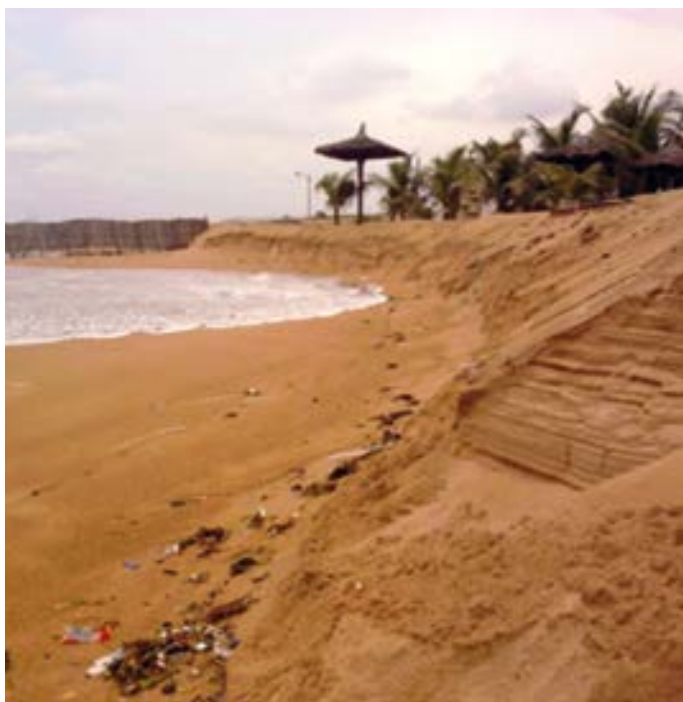
Importante érosion (plage réflexive) dans le secteur face au port (Source antenne nationale MOLOA du Bénin)
