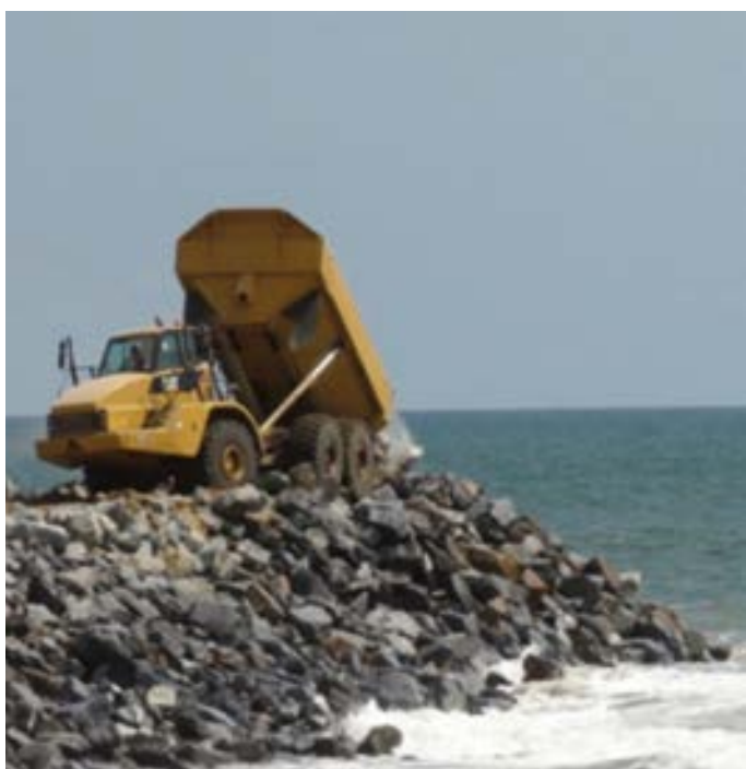
Aménagement du système d'épis à l'Est du port de Cotonou (Source antenne nationale MOLOA du Bénin)
