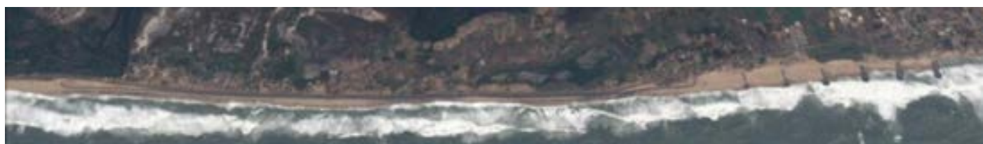
Construction d'ouvrages de protection de la route côtière entre Salo et Anloga (2010-2013) rive gauche de la Volta
