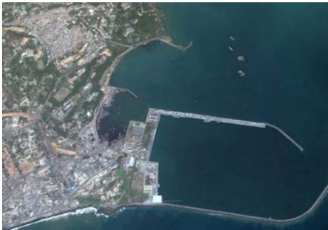
Port de Sekondi en 2013 (Source : Google earth) Le port de Sekondi n'a pas fait l'objet de grands travaux depuis 2010.
