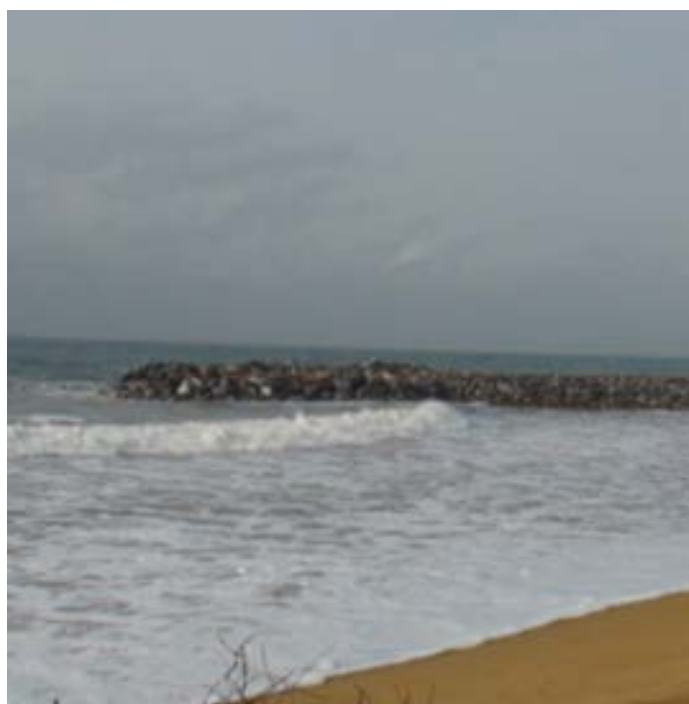
Aménagement du système d'épis à l'Est du port de Cotonou (Source antenne nationale MOLOA du Bénin)
