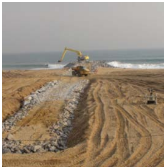
Aménagement du système d'épis à l'Est du port de Cotonou (Source antenne nationale MOLOA du Bénin)
