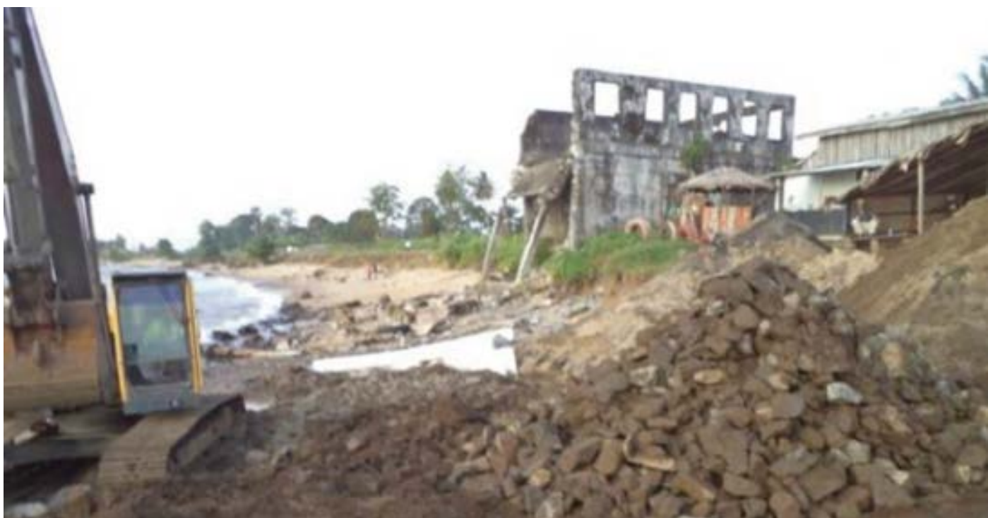
Mise en place de la première section de GeoTextile mat (couleur blanche dans l'image) en dessous de l'ouvrage pour protéger la structure de béton à Buchanan
