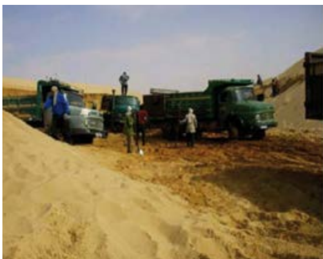
Travaux de confortement du cordon dunaire à Nouakchott
