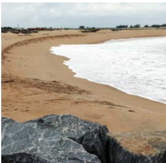
Reprise d'érosion entre les épis de l'aménagement de Keta (formation d'une berme de haut de plage)
