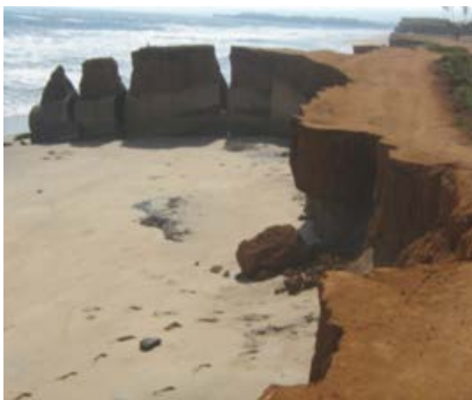
Coupure de la route à l'Est de la carrière de sable de San Pedro sur la plage de la lagune Digbougé (2009)
