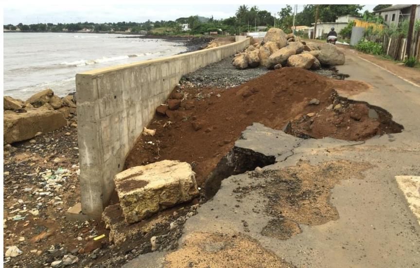
*Figura 16: Estrada destruída por erosão pelo mar na zona costeira. Um muro de contenção está em construção para substituir o troço anterior (vestígios ainda visíveis) e proteger a estrada. Foto: Naraya Carrasco.*
