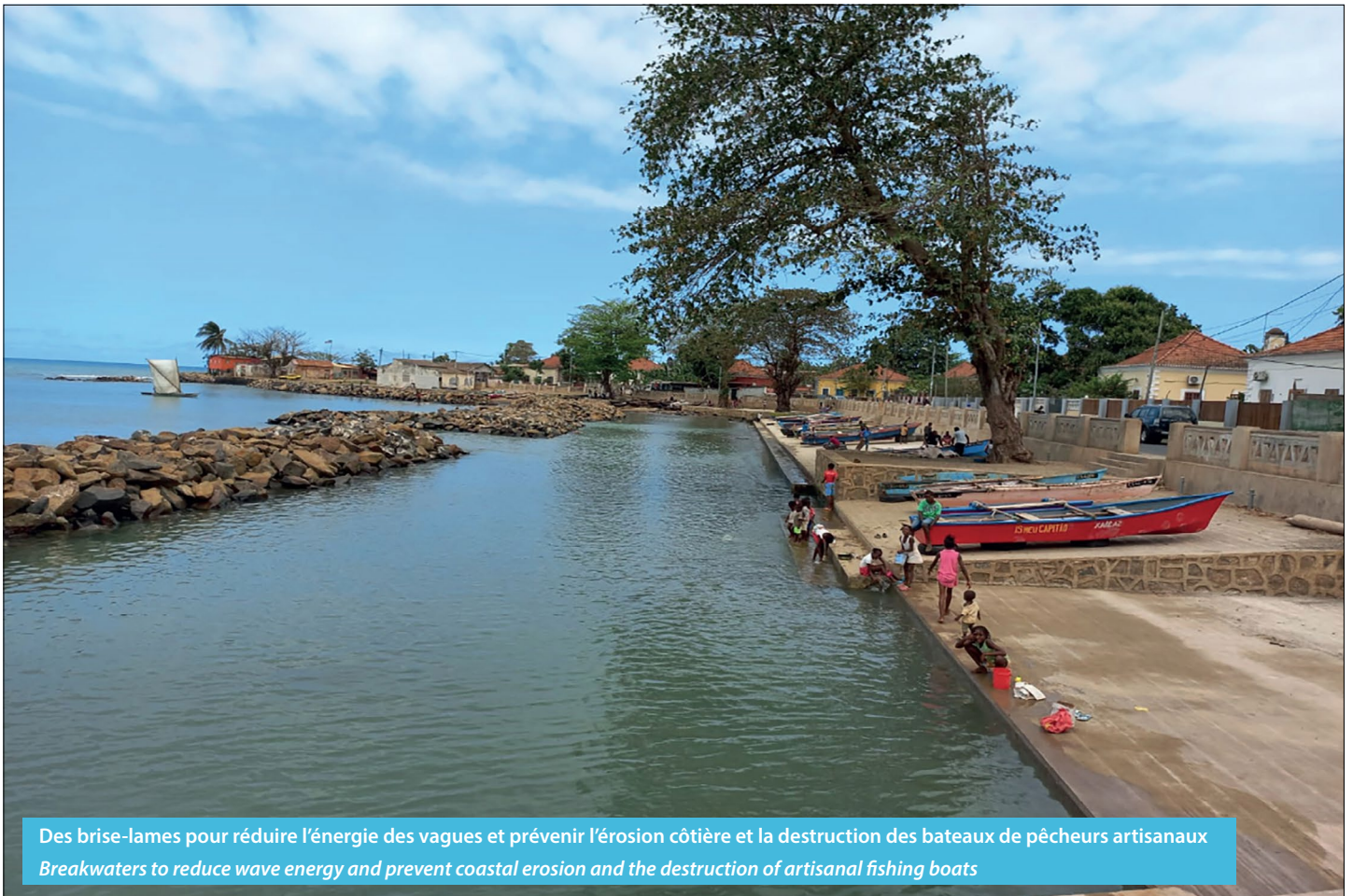
Mise en place de bermes rocheuses pour protéger les communautés contre l'érosion côtière Establishment of rock berms to protect communities against coastal erosion
