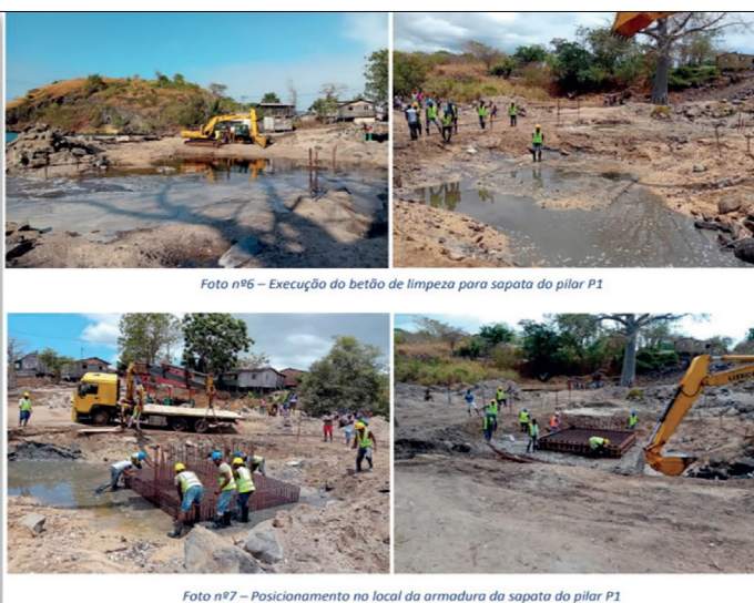
Foto nº7 – Posicionamento no local da armadura da sapata do pilar P1
