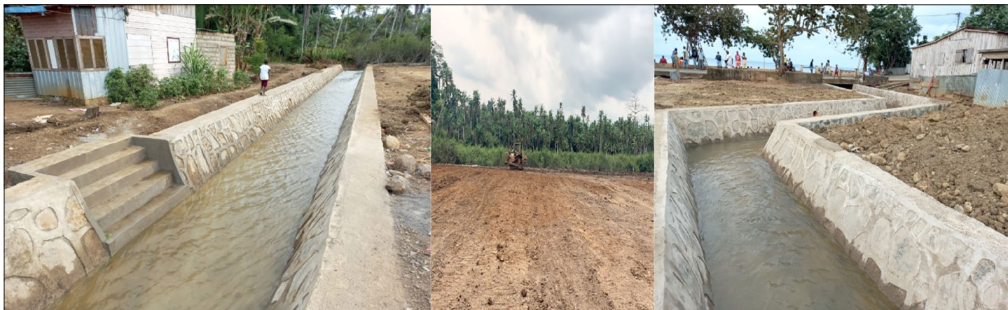
Le drainage des rivières et des eaux de pluie pour éviter les inondations
