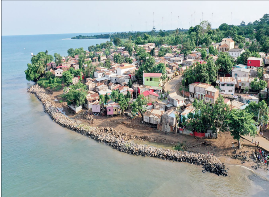
Mise en place de bermes rocheuses pour protéger les communautés contre l'érosion côtière Establishment of rock berms to protect communities against coastal erosion
