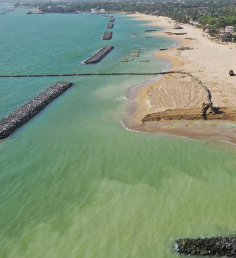
Rechargement de plage à Saly-Portudal, Sénégal. Photo : Projet de Développement du Tourisme et des Entreprises (PDTE) au Sénégal financé par la Banque mondiale
