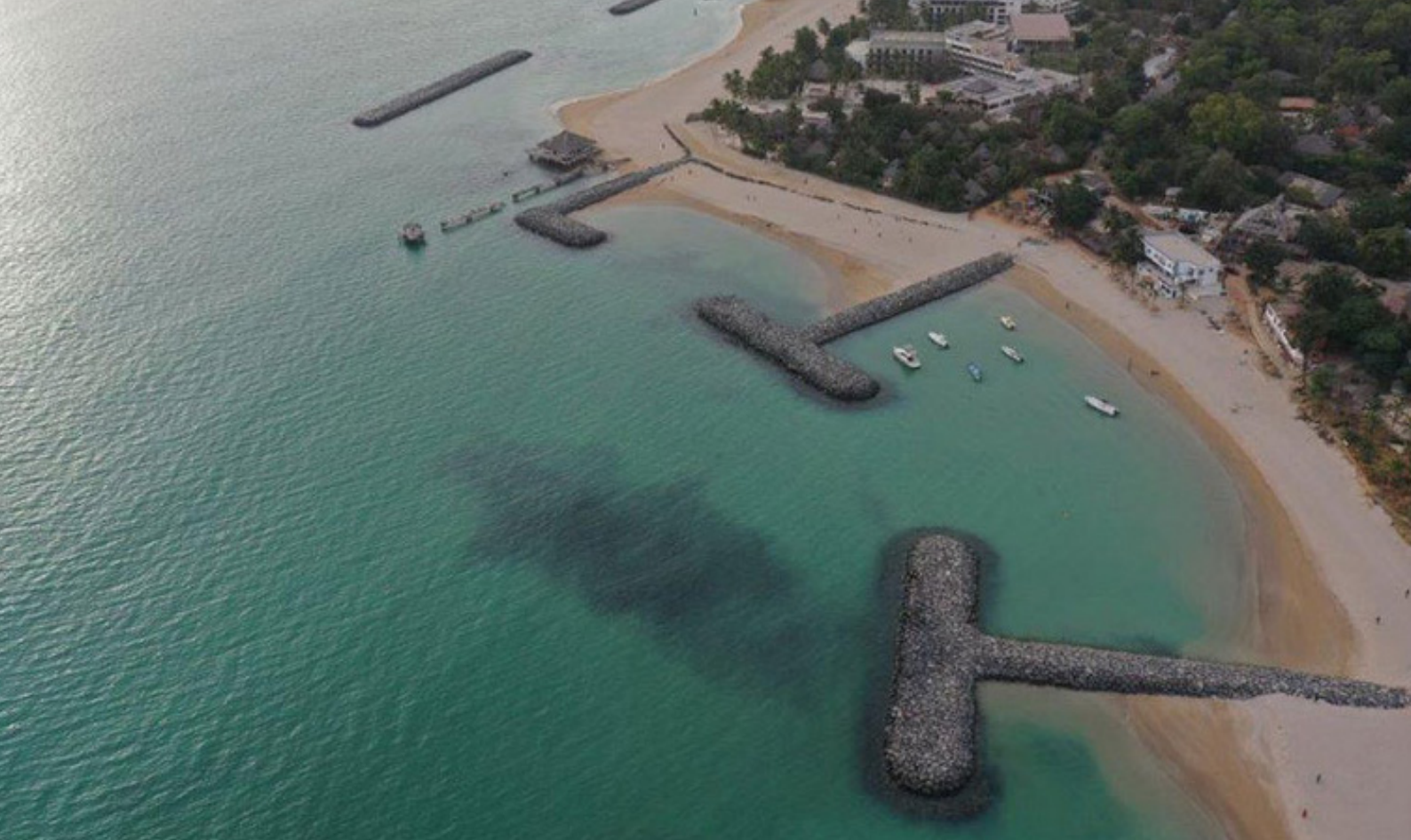
Epis à Saly-Portudal, Sénégal. Photo : Projet de Développement du Tourisme et des Entreprises (PDTE) au Sénégal financé par la Banque mondiale
