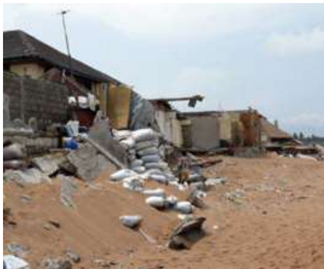
Destruction des installations de haut de plage à l'Est des installations de l'embouchure du chenal d'accès au port (MOLOA)
