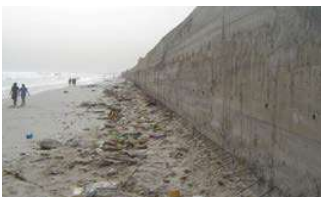
Mur de protection en construction à Mbao (source : diagnostic national)
