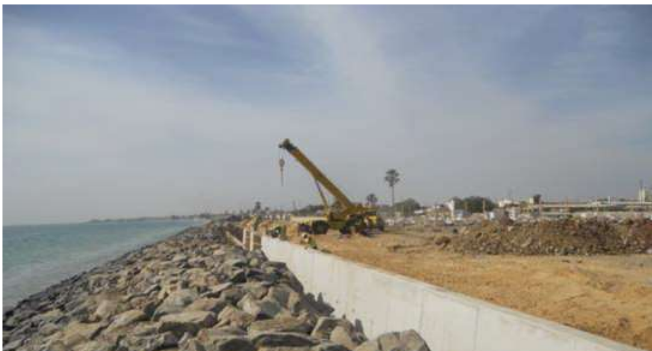
Construction de la digue de Thiawlène en 2012
