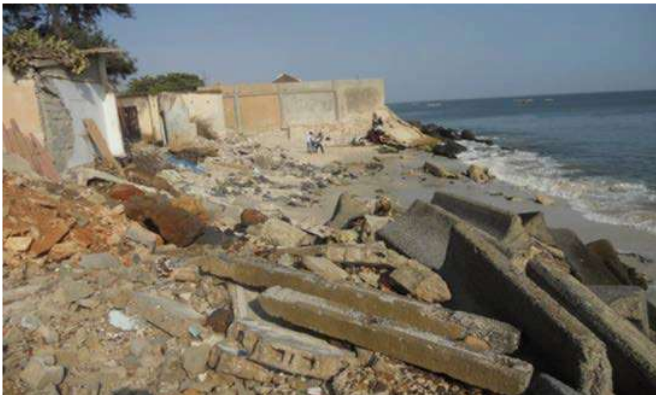
Forte érosion à Mbao en mai 2014 (source : antenne nationale MOLOA du Sénégal)
