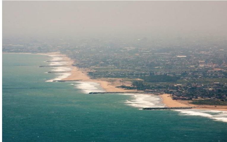
Figure 4.8 Batterie de sept épis installés depuis 2014 dans la crique à l'aval de l'épi de Sifato (P-LEC/DABC, 2014).
