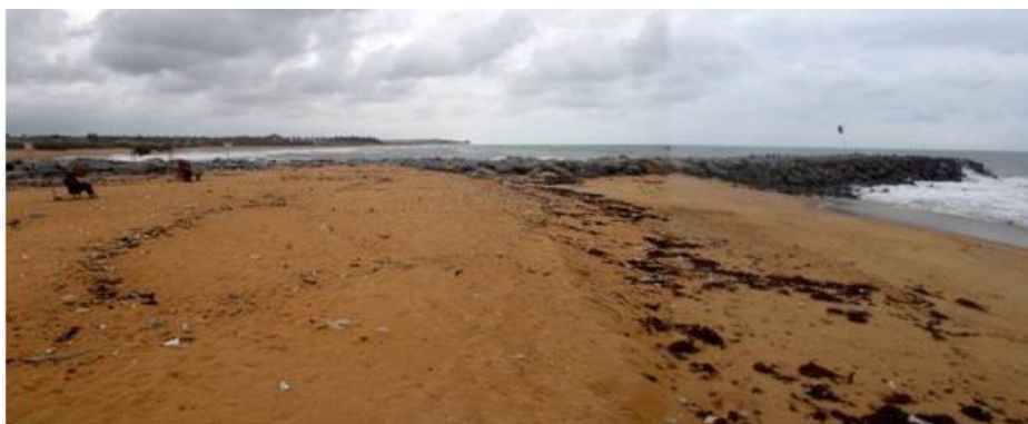
Figure 4.9 Crique formée par l'érosion à l'aval du champ d'épis (cliché Laïbi, 2015).
