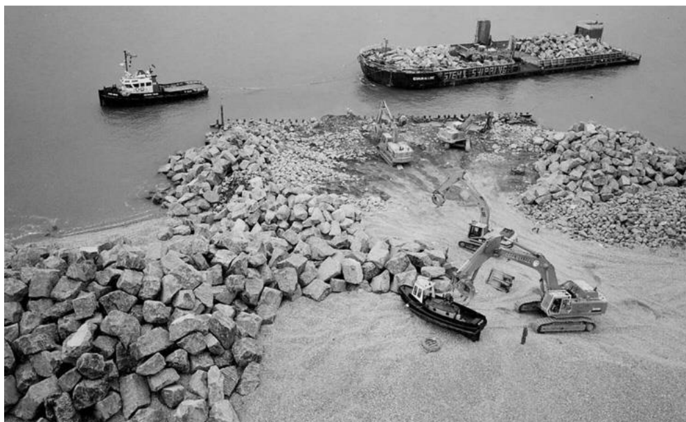
Photo 10 : Déchargement d'une barge transportant des enrochements
