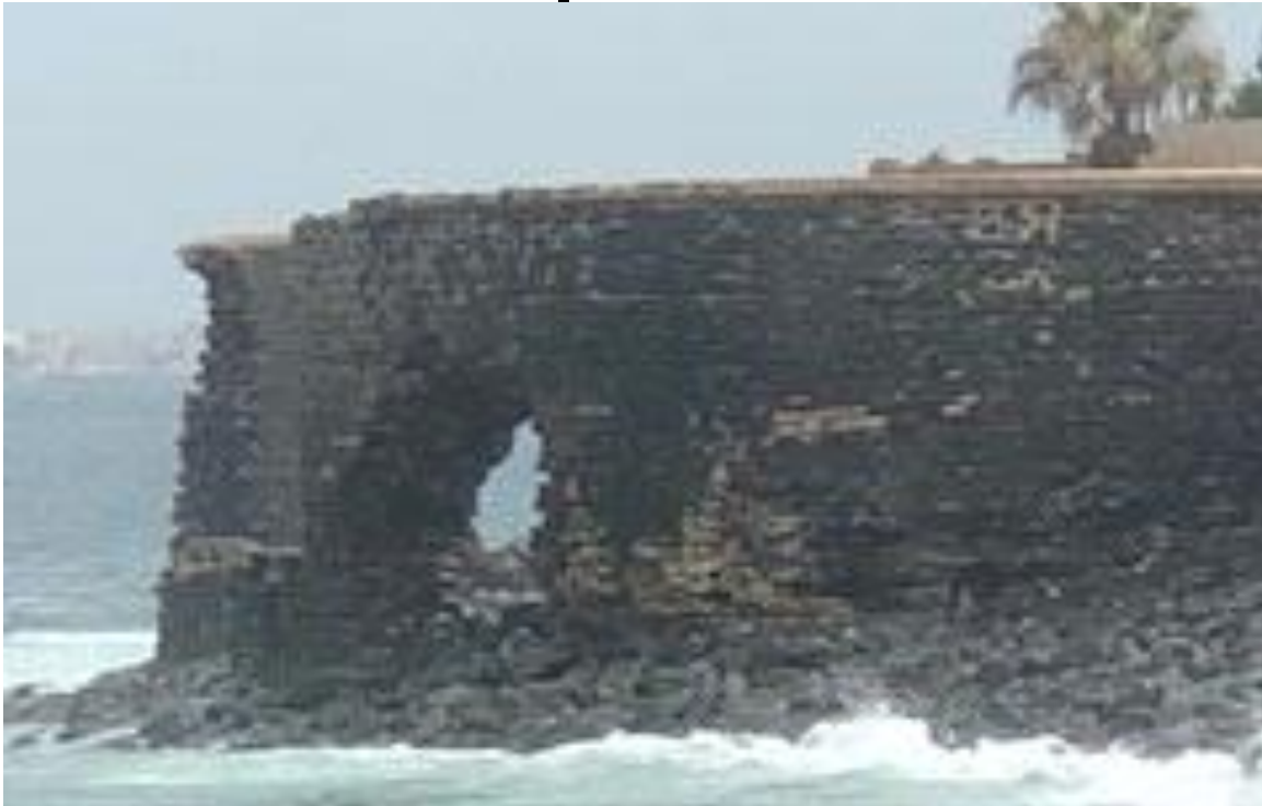
Photo 3: Mur de la Batterie
