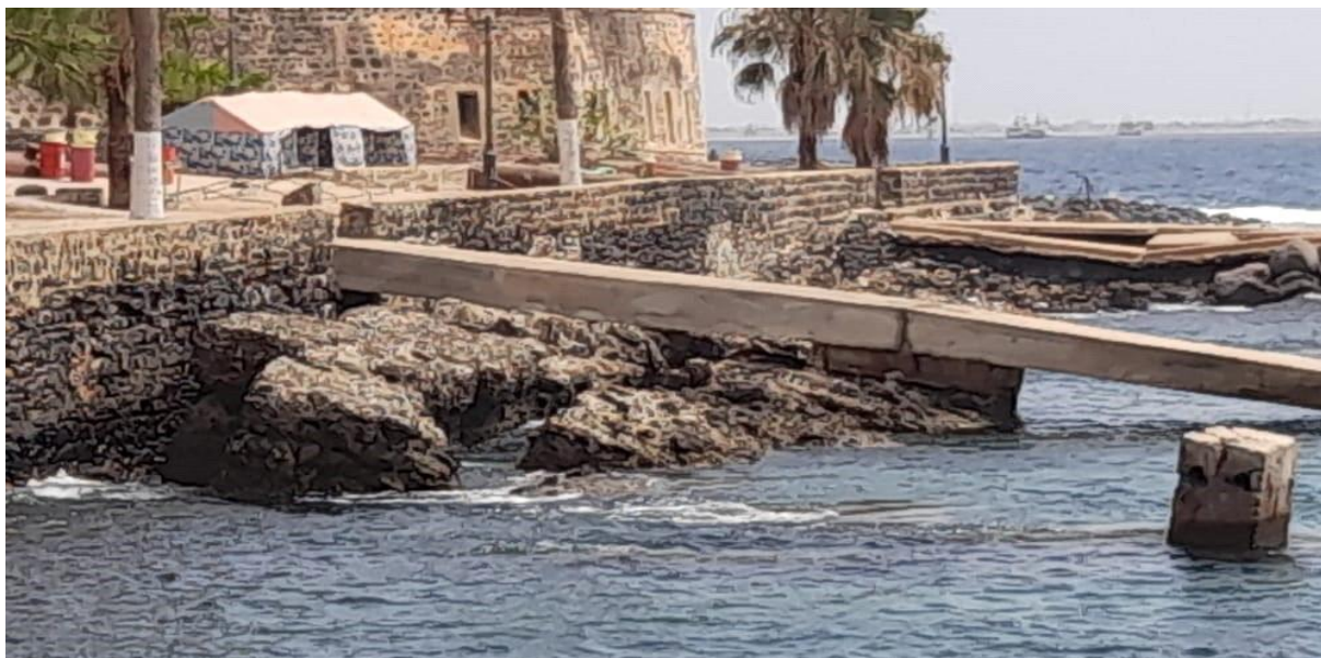
Photo 1: Basculement des quais de débarquements
