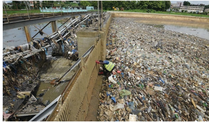
Figure 14 : Barrage en amont de la lagune Ébrié à Abidjan
