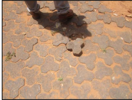
Photo 15 : Rue en pavés plasto-sables (Expérience pilote de l'Ong RESEDA)
